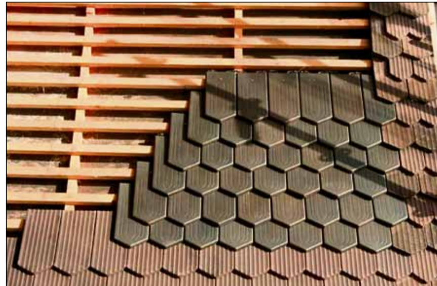
Verlegte ATMOVA-Ziegel auf dem Dach.
