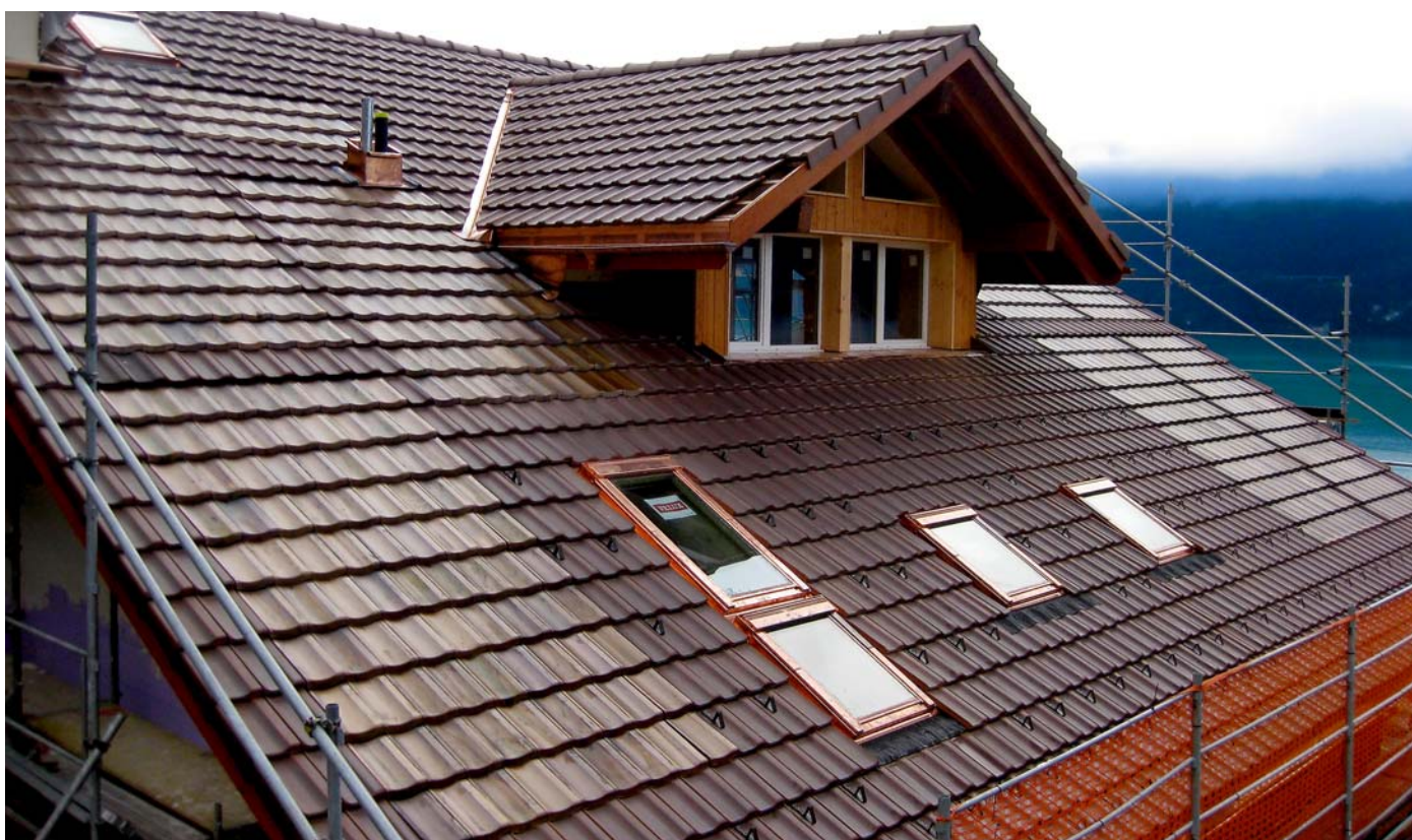
Die wärmeaktiven Atmova-Kupferdachziegel (bei Montage noch hell, werden danach dunkler) auf einem Dach der Kurklinik Eden am Brienersee. (Fotos: Atmova)
