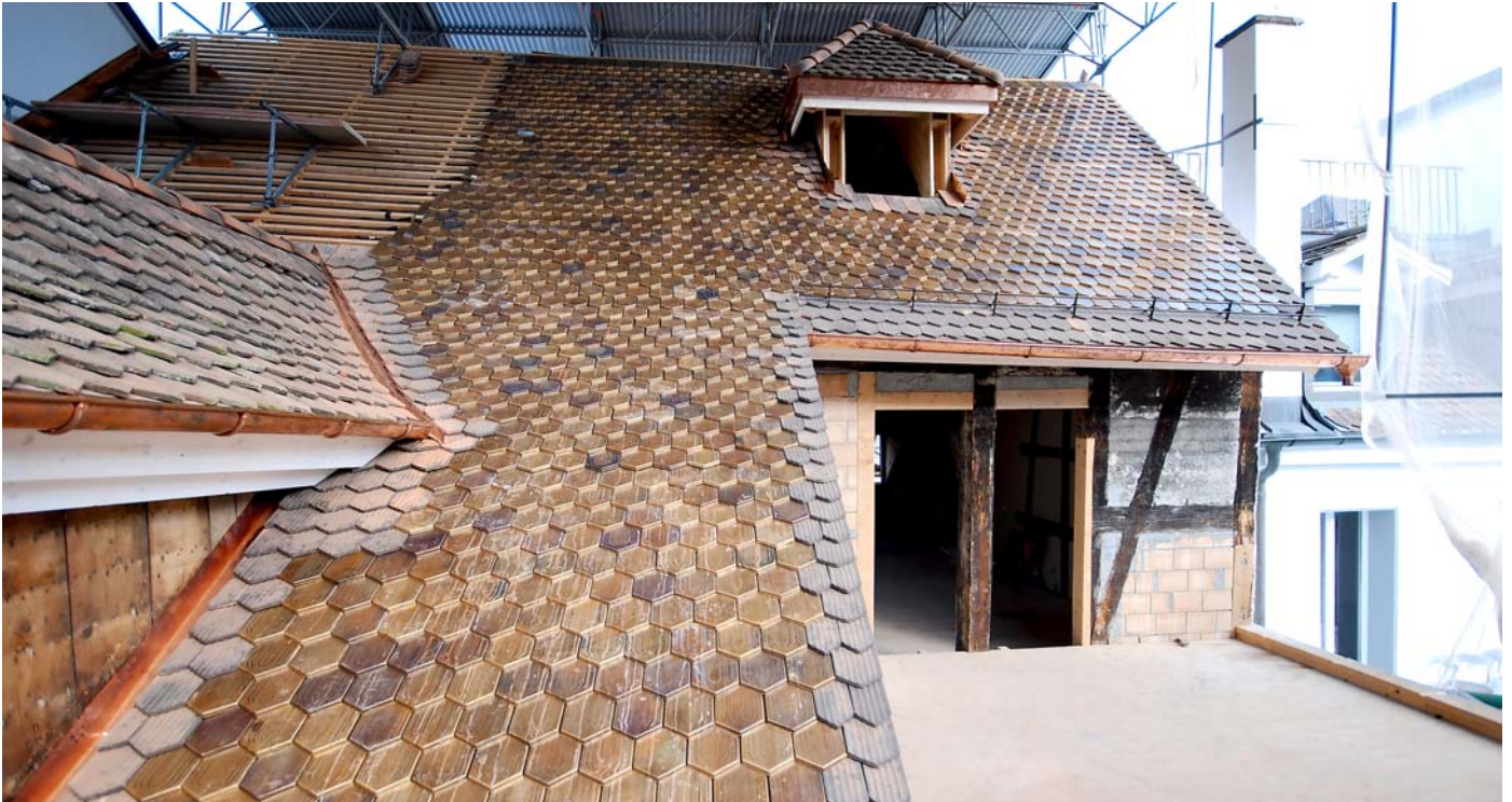
Das 2010 fertig sanierte, 500 Jahre alte «Haus der Umwelt» in der Luzerner Altstadt bezieht seine Wärmeenergie für Heizung und Warmwasser aus Atmova-Biberschwanz-Kupferdachziegeln, die eine Fläche von 120 m 2 belegen und perfekt mit den echten Ziegeln harmonisieren.
